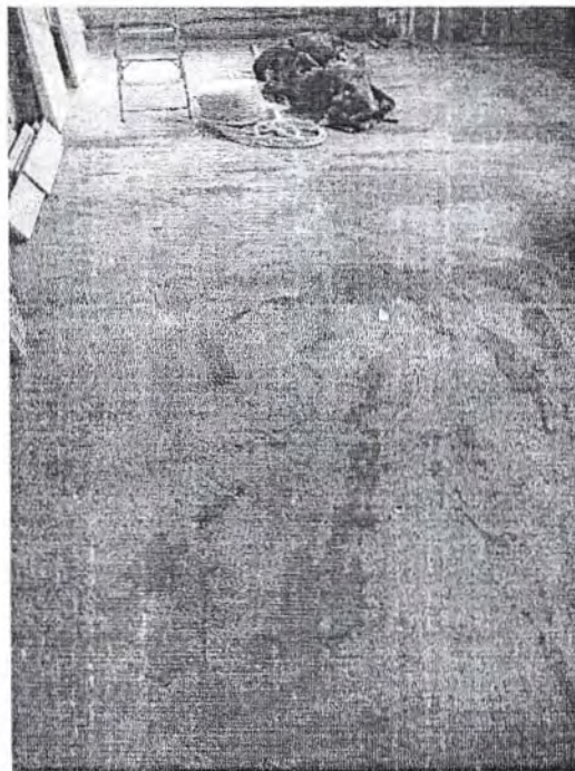
Retirada/demolição do piso laminado
