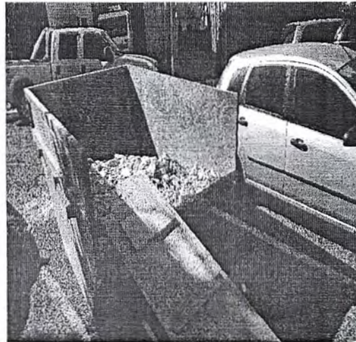
Caçamba contratada para retirada de entulho
